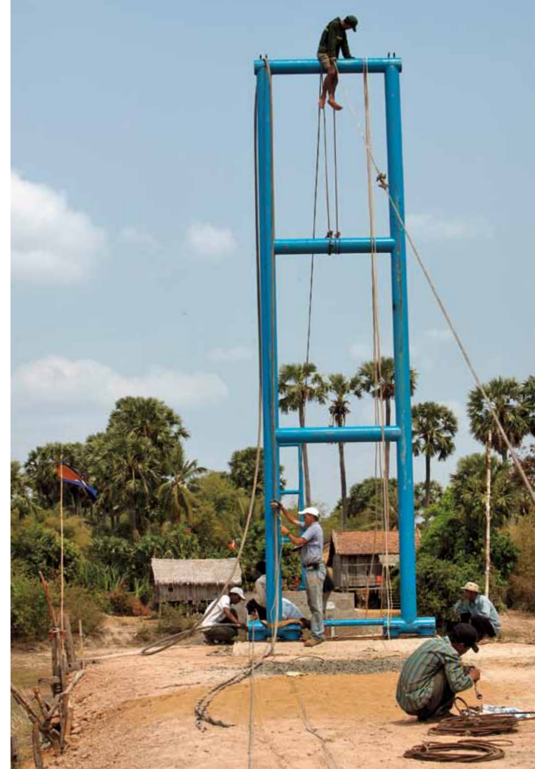
Nachdem die Brückenbauer die Trageile über den Fluss gezogen haben, richten sie die Gelenktürme auf.
